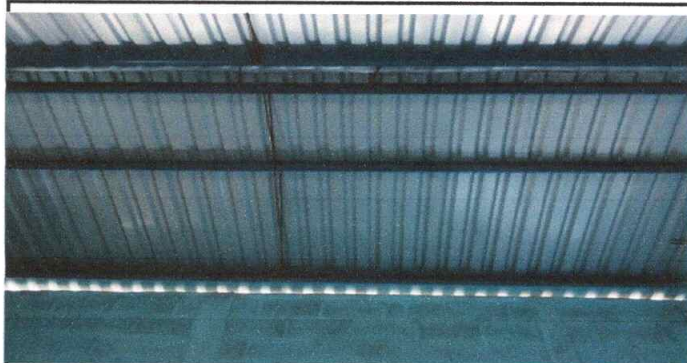
Foto 6: instalacion de energia eléctrica Módulo 1 y Módulo 2
