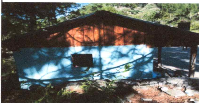
Foto 4: sustitucion de lámina por lámina troquelada aluzinc calibre 26 módulo 2
